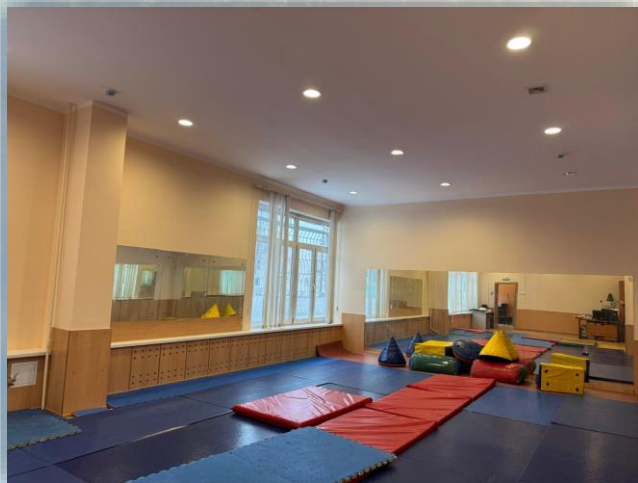
Установка пожарной сигнализации (Алтуфьевское ш., д. 102Б)
