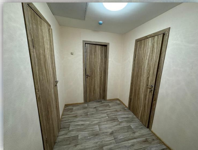
Ремонт помещений (Алтуфьевское ш., д. 102Б)
